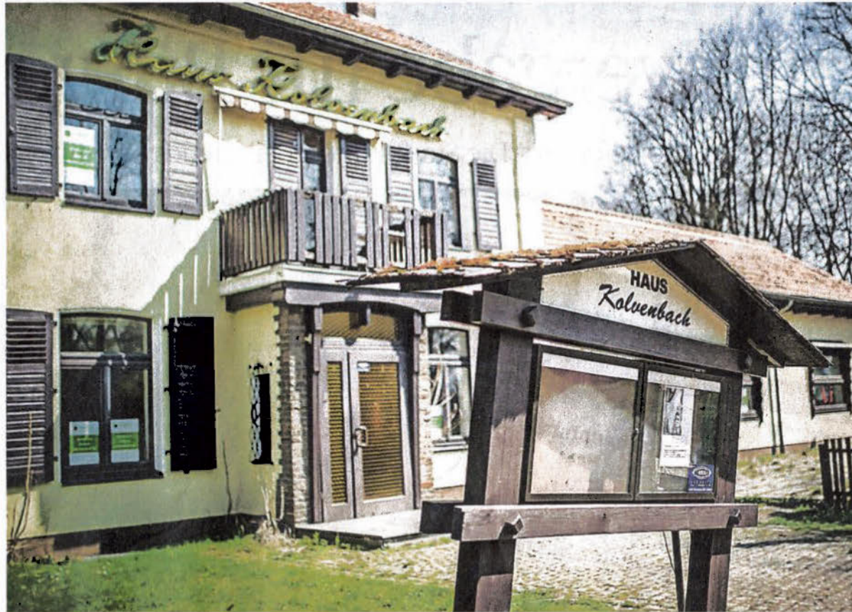
Das Haus Kolvenbach am Stoffeler Kapellenweg im Südpark war früher ein beliebtes Ausflugsziel, wurde einst auch als Tanzschule genutzt. Seit vielen Jahren steht es inzwischen leer.
